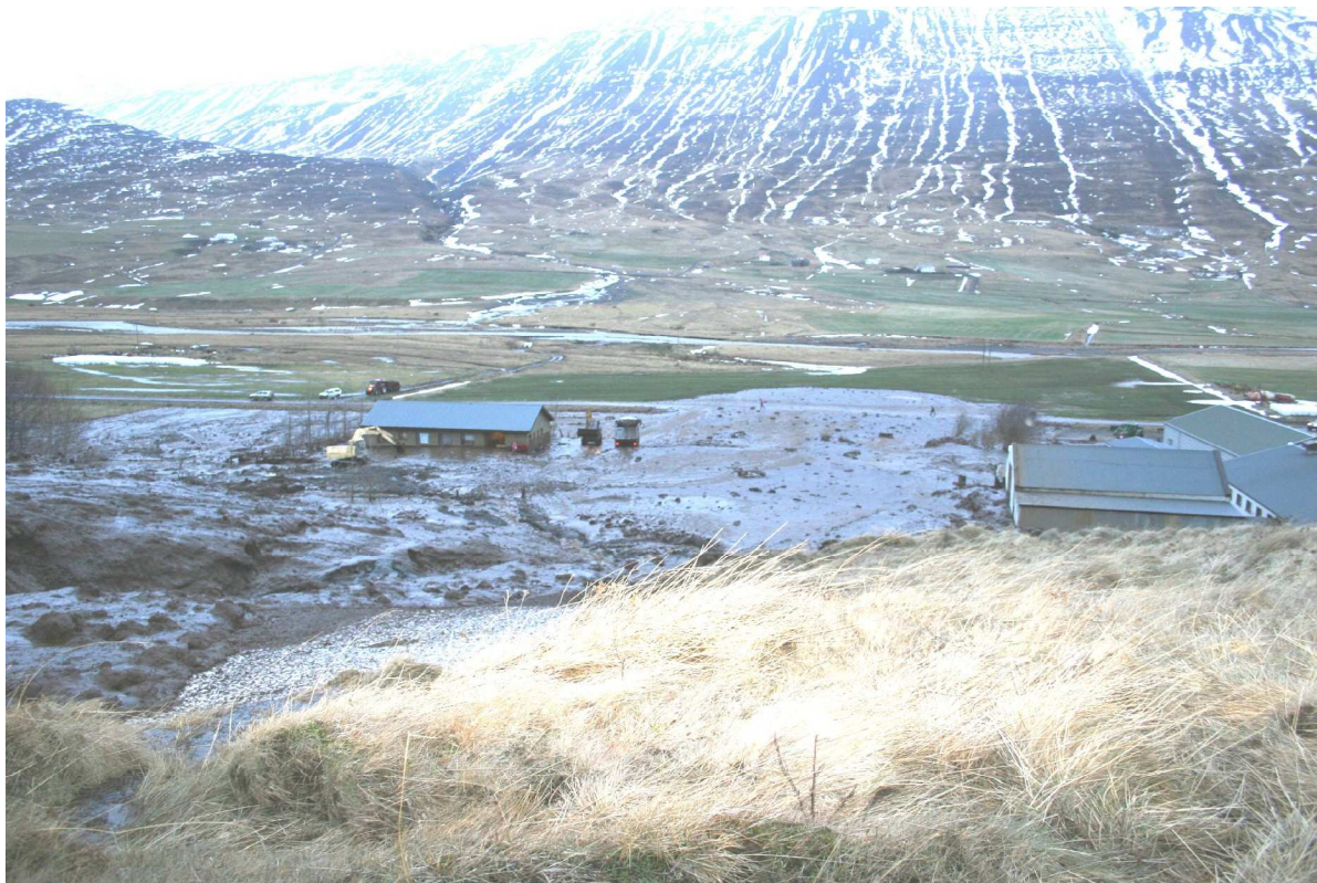
7. mynd. Séð yfir skriðuna sem féll á Grænuhlíð að morgni 20. desember. Húsin sem skriðan tók stóðu beint fyrir neðan farveginn, við hliðina á húsunum hægra megin á myndinni. Á myndinni má greina hve hátt aurinn náði upp á vegg íbúðarhússins en þegar myndin er tekin er verið að byrja að hreinsa hann frá húsinu. (Ljósmynd Valur Magnússon 2006).
